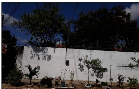
Poste de medição. no muro da escola
